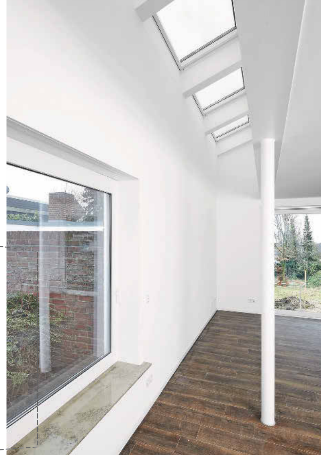
Zusätzliches Licht von oben: Für das Lichtband wurden Stahlträger eingezogen und ein Kombi-rahmen mit fünf Fenstern eingesetzt.
