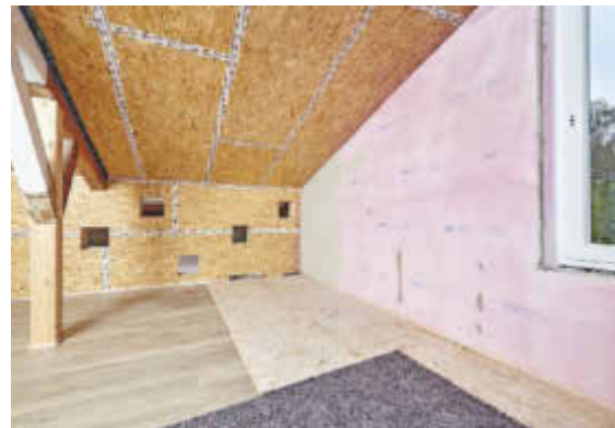
Mit den diffusionsoffenen Dämmplatten wurden alle Außenwände gedämmt; sie lassen sich mit dem Fuchsschwanz an jede Wand anpassen.
