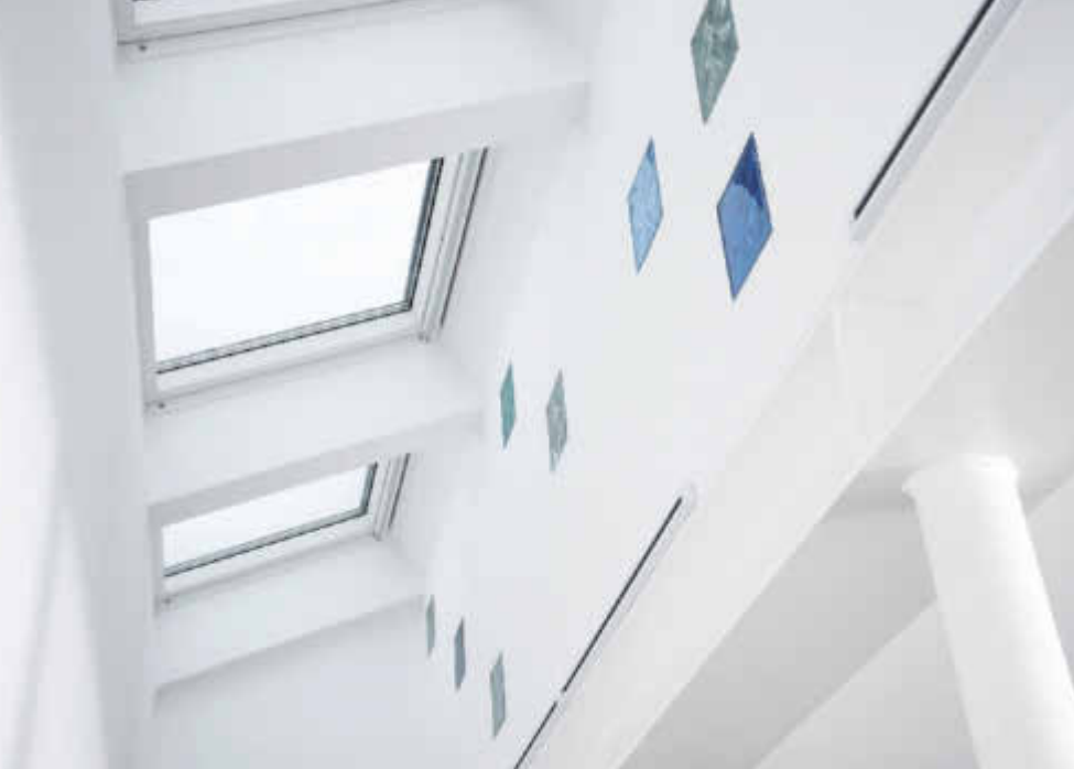
Glasbausteine lenken Tageslicht in das Obergeschoss.
